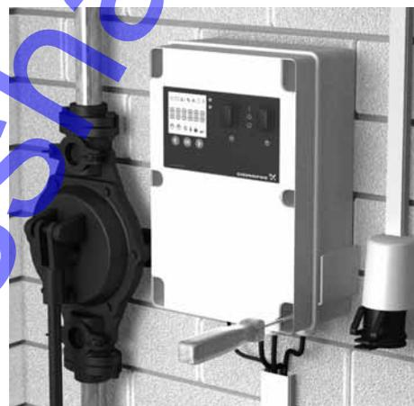
Abb. 8 Anbringen der Steuerung LC 221
